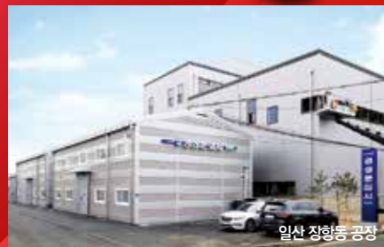
일산 장항동 공장
